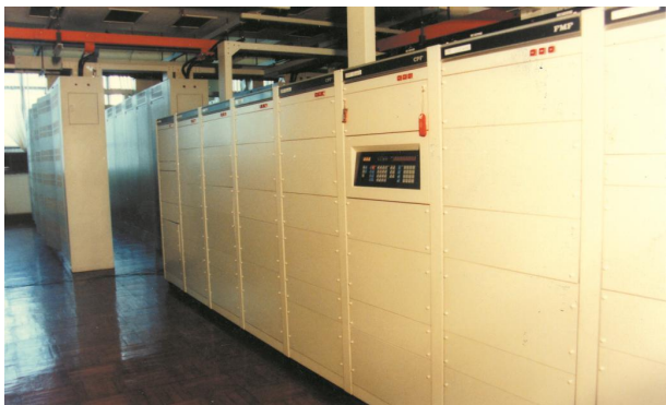
1982 年全国首次引进的 F-150 型市话程控 1 万门，设东街母局（8000 门）、台江模块局（2000 门）。图为东街口邮电大楼二楼的东街母局机房
